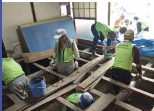
床下の土砂かき
