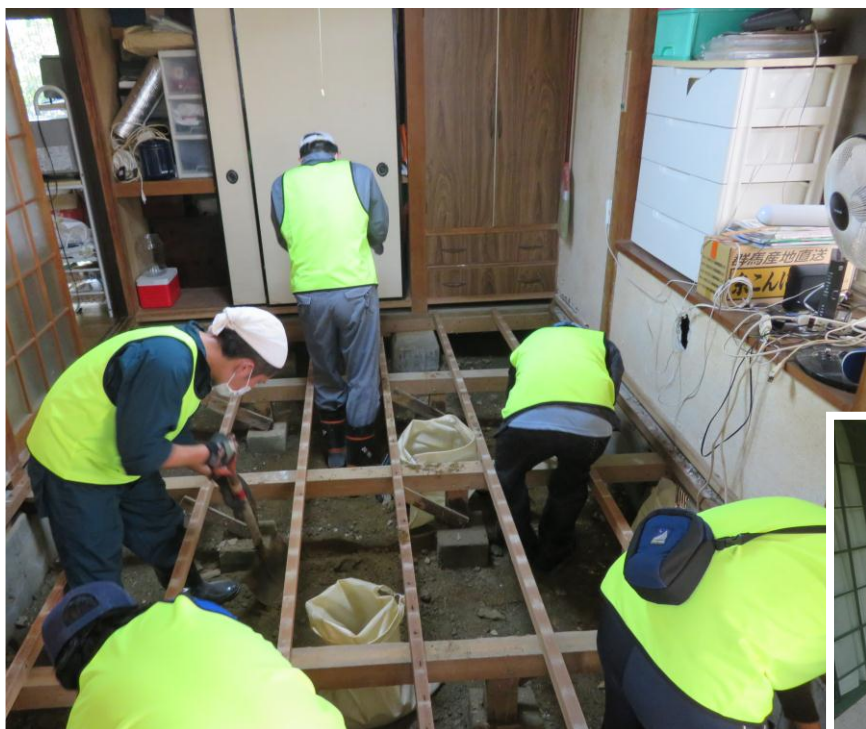
床下の土砂出し
